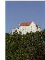
RieRo.I, Ostfassade, DI014829, BSV-
