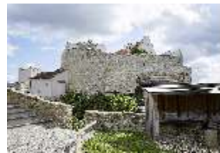
RieRo.I, Südfassade, DI014838, BSV-
