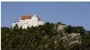
RieRo.I, Ostfassade, DI014830, BSV-
