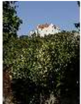
RieRo.I, Ostfassade, DI014826, BSV-
