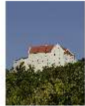
RieRo.I, Ostfassade, DI014825, BSV-
