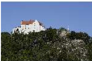
RieRo.I, Ostfassade, DI014831, BSV-
